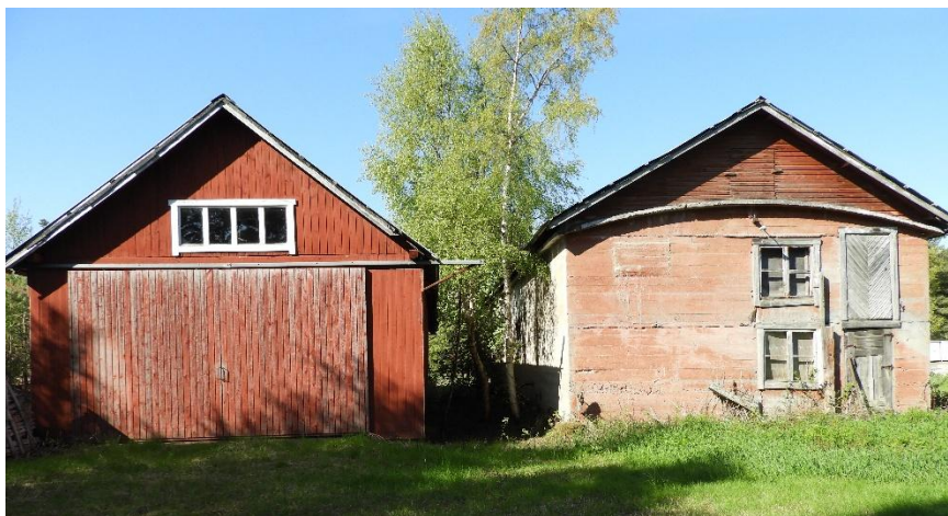
kuva 40. Sahalan kiinteistön (72-401-7-43) vanha myllyrakennus oikealla.
