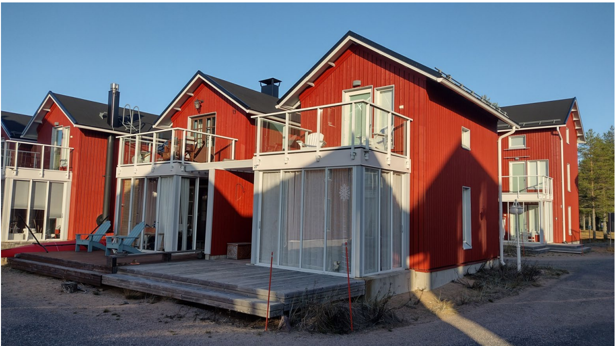
Kuva: Nykyisellä asemakaava-alueella loma-asunnot muodostavat tiivistä korttelirakennetta dyynivyöhykkeen taakse.
